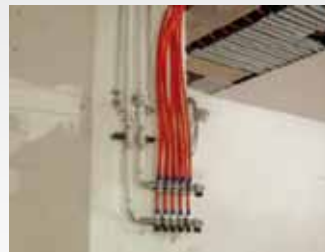
Scheidslijn: de regelcircuitverdeler
